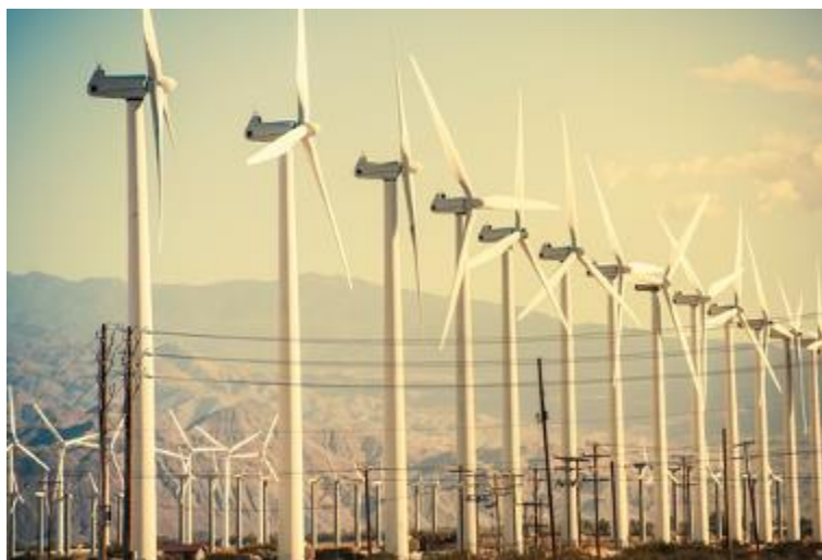
Parque eólico em operação na cidade de Coachella, no estado da Califórnia (EUA)
